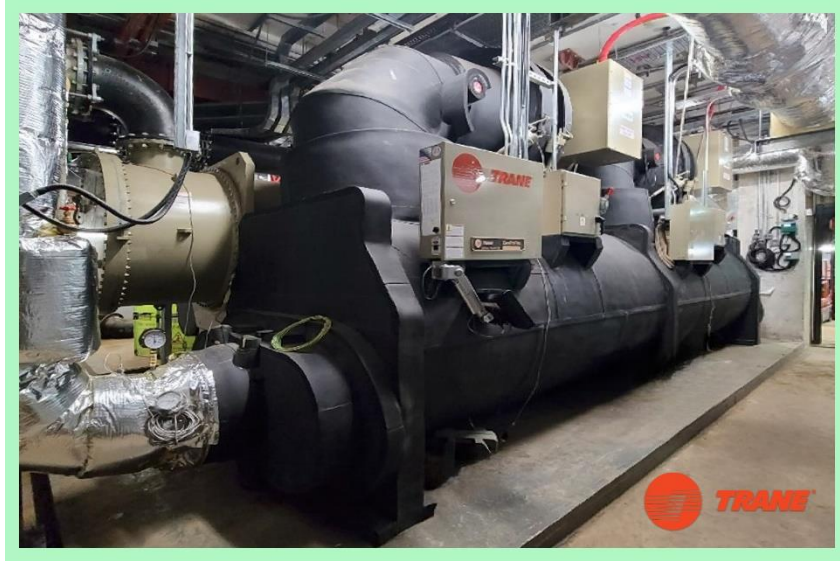
配備 HFO 製冷劑 R514A 的 2,200 噸特靈 Duplex™ CenTraVac® 冷水機組
